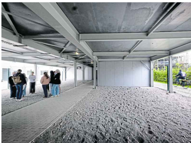
Weil hier Versorgungsleitungen verlaufen, wurde untersucht, die Fläche zu belegen. Also entstand ein abgesperrter Innenhof.
