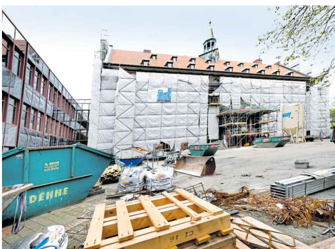
Die Sanierungsarbeiten am ESG laufen nach Plan. Der Lehrerparkplatz vor dem Eingang wird zukünftig entfallen. Foto: Andreas Frücht
